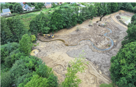
La Flume à Langouët (35), lors des travaux de restauration Été 2025
