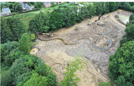
La Flume à Gévezé (35), lors des travaux de restauration Été 2025
