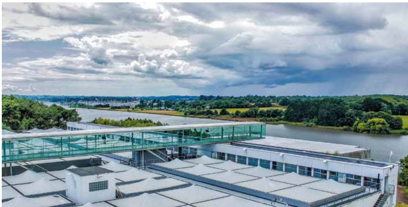
Usine d'eau potable de Vilaine Atlantique, Férel (56)
