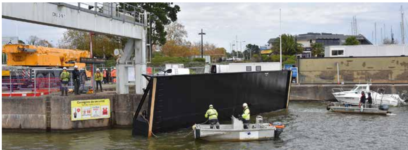
Batardage de l'écluse, Arzal (56)
