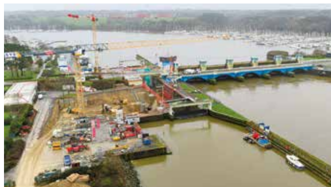
Travaux de construction de l'écluse anti-salinité, Arzal (56)
