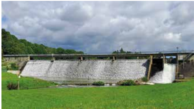
Barrage de la Cantache
