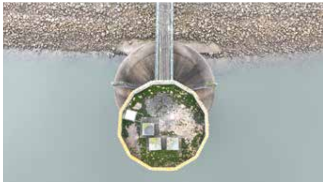
Barrage de la Valière
