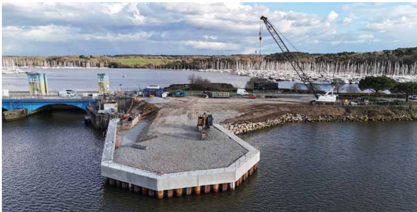
Rénovation des gabions aval, barrage d'Arzal (56)
