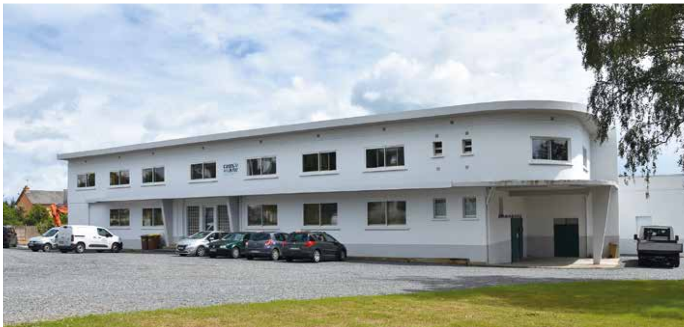
Nouveau siège administratif d'Eaux & Vilaine depuis le 1 er janvier 2025, Redon (35)
